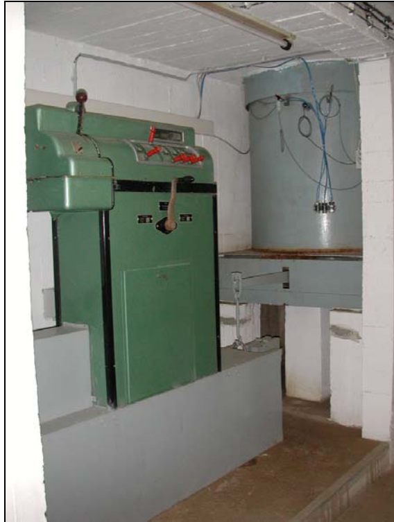
Abb. 4 Blick auf ein Lysimeter mit Balkenwaage im Keller der Lysimeteranlage
