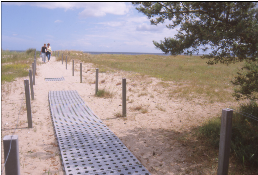
Abb. 2: Zugang „Mukran Neu“, die Befestigung des Weges und die Neugestaltung des Zaunes könnte in Zukunft die Trittschäden minimieren
