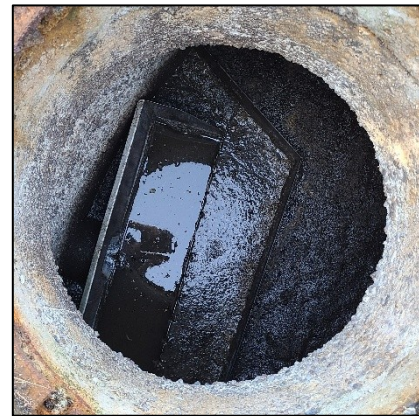
Abb. 66: Überfüllter Schlammabzug
