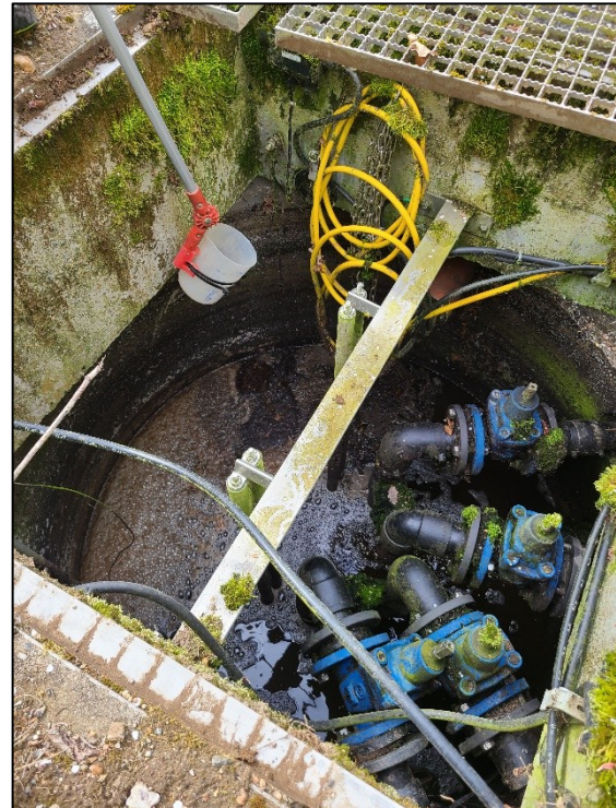
Abb. 37: Animpfmateriale nnahme aus dem Rezirkulationsschacht
