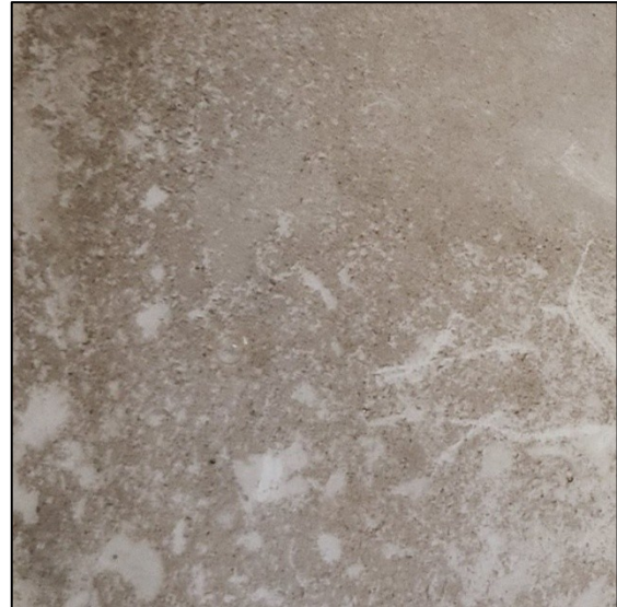
Abb. 83: Nicht ausgeschwemmter Bodensatz im Feed-Tank, Nahaufnahme
