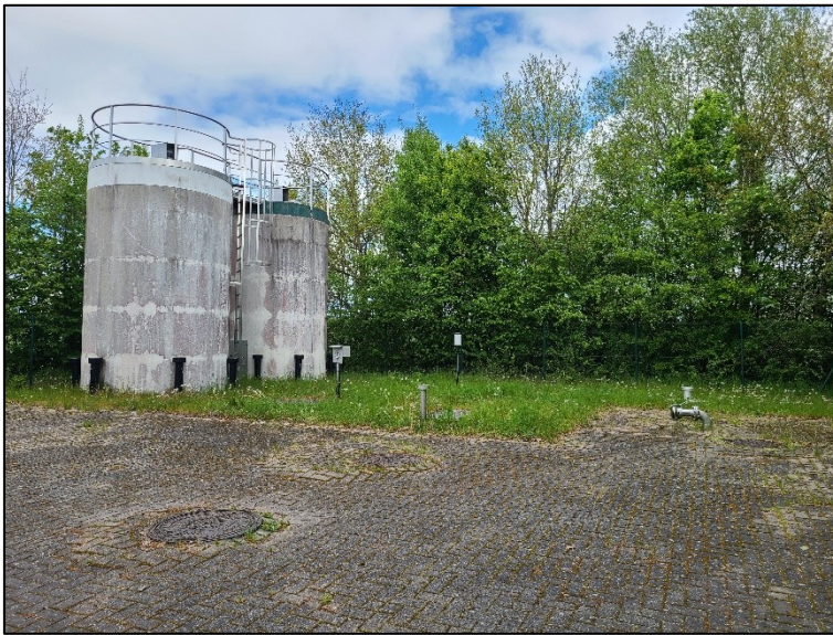
Abb. 33: Kläranlage „Dänschenburg - Möllerdamm“
