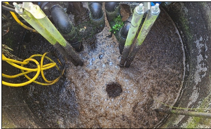
Abb. 65: Schlammbelasteter Rezirkulationsschacht
